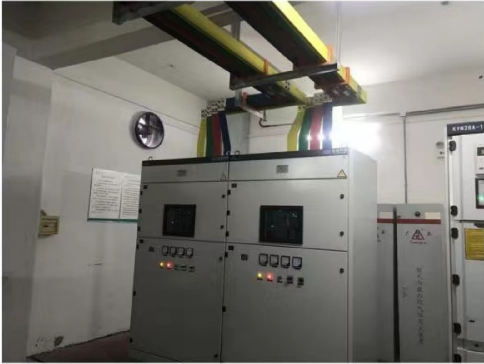
图 10 光伏发电项目
