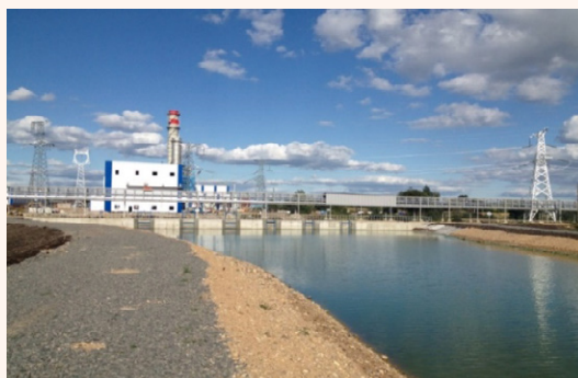
循环水引水渠
